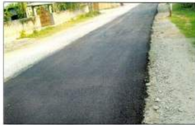
कोल्ड मिक्स सड़क निर्माण सतह
